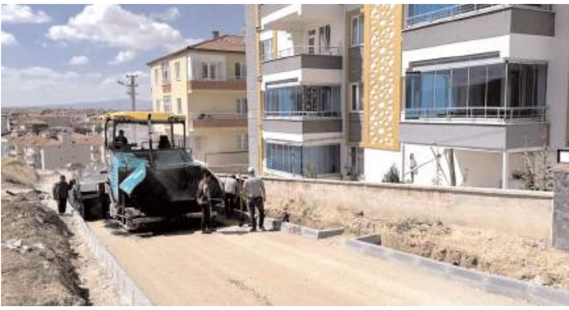
Mehmet Akif Ersoy ve Sülüklüevler Sokaklarda asfalt çalışması yapıldı.
