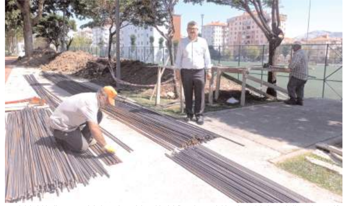
Park içindeki tribünün üzerinin kapatılması için yüklenici firma hummalı bir çalışma içinde. Mahalle Muhtarı Arif Çınar da bu çalışmaları yakından takip ederek işin biran önce tamamlanması için çaba gösteriyor
