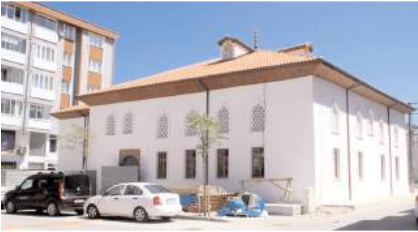
Kulaksız Camiinde restorasyon çalışmaları devam ediyor.
