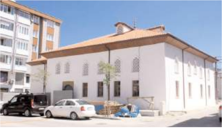
Kulaksız Caminde restorasyon çalışmaları devam ediyor.
