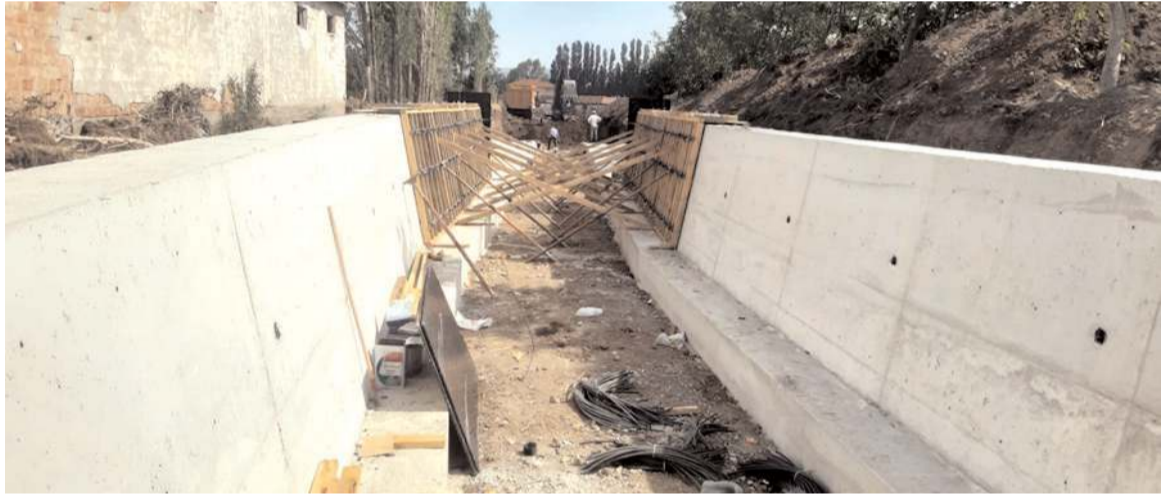
Kanalın yapılmasıyla bölgedeki tarım alanları taşkın riskine karşı daha güvenli hale getirilecek.
