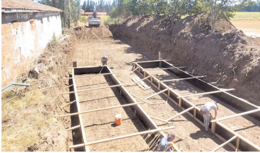
Beldede DSİ tarafından taşkın koruma kanalı yaptırılıyor.
