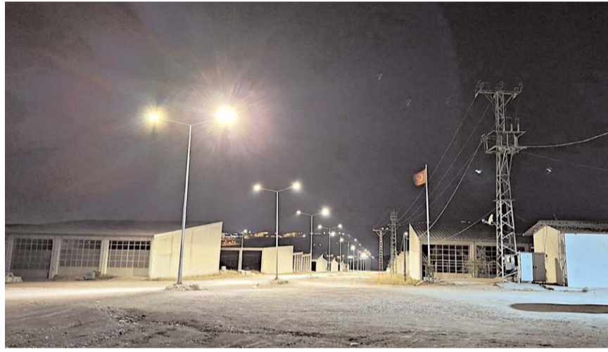
2. etap ışıklandırma çalışması da Makineciler Bölümü'nde gerçekleştirildi.
