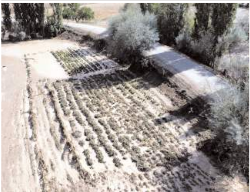
Şiddetli yağış sonrası oluşan sel tarım arazilerine zarar verdi.
