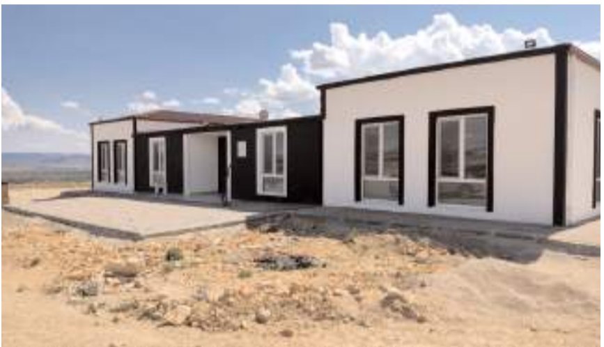
Projenin şantiye binası yapıldı.
