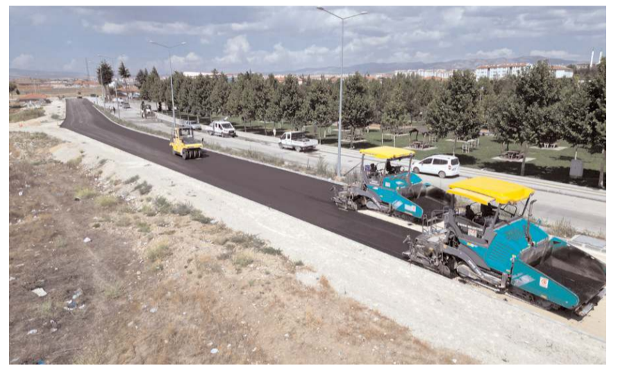
Daha önce stabilize olan yollara sıcak asfalt seriliyor.
