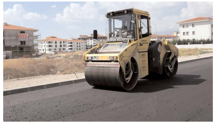
Daha önce stabilize olan yollara sıcak asfalt seriliyor.
