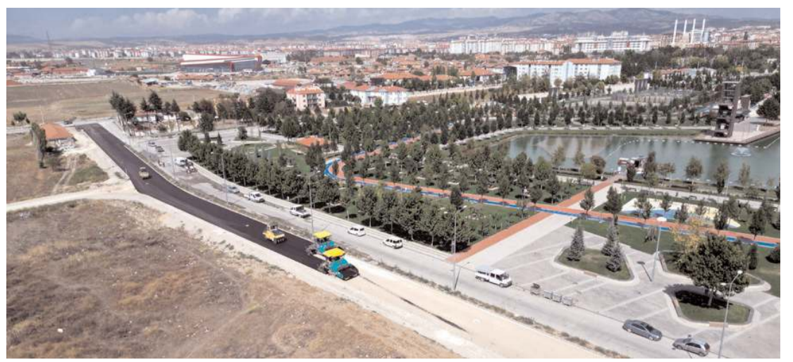
Millet Bahçesi çevresinde bulunan yollar sıcak asfalt yapılıyor.
