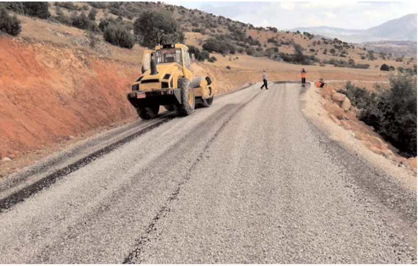
Yaklaşık bin 300 kişinin yaşadığı Öbektaş köyünde yol yapım çalışmaları devam ediyor.
