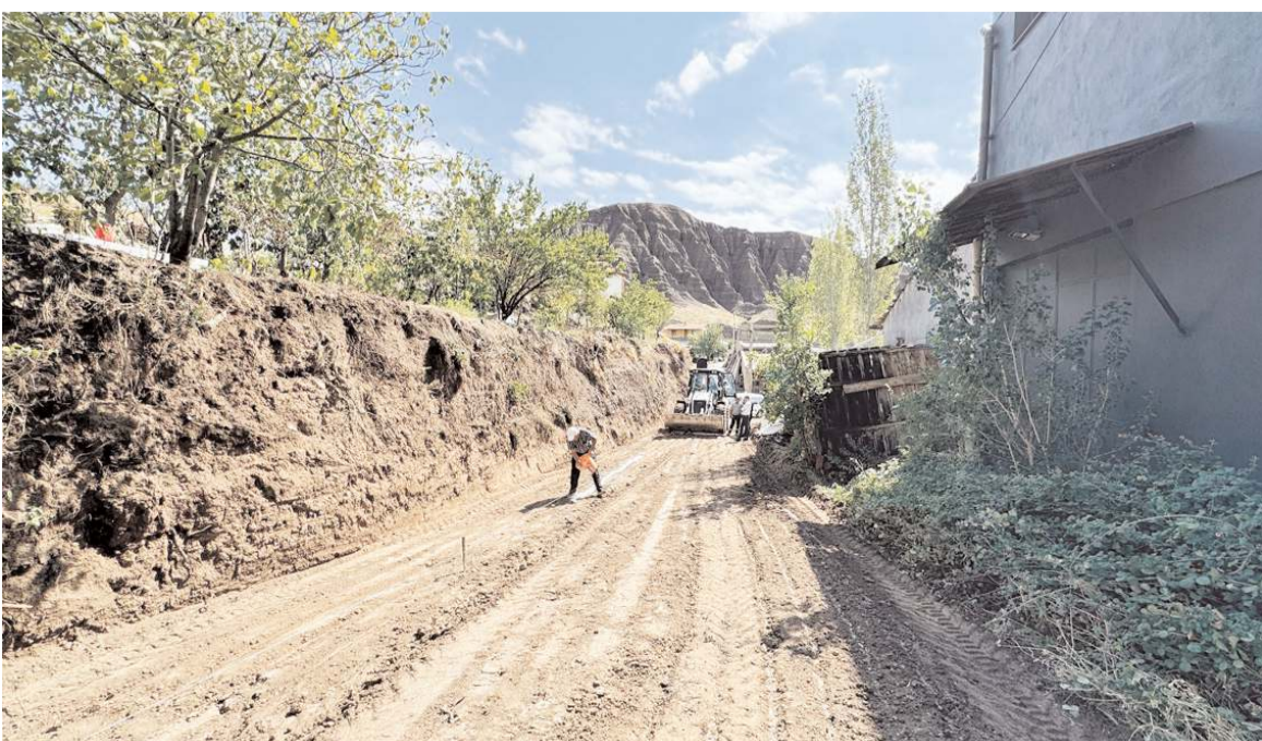
Bölgede su baskını riskini önlemek amacıyla yol ıslahı çalışması başlatıldı.
