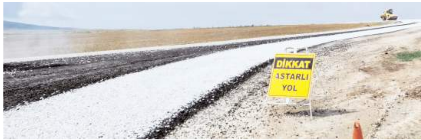
Aşınan yollarda sathi kaplama yapıldı.
