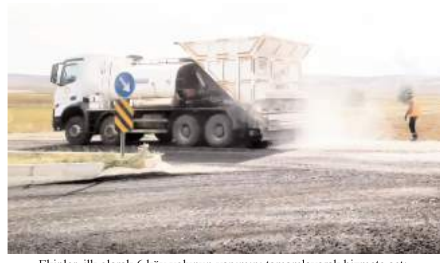
Ekipler, ilk olarak 6 köy yolunun yapımını tamamlayarak hizmete açtı.
