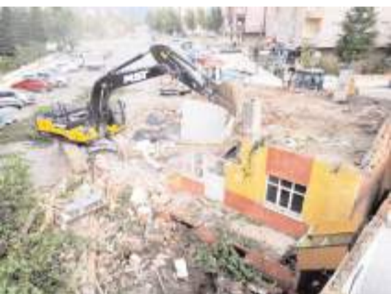
Cadde de yol üzerinde kalan 3 yapının yıkımı tamamlandı.
