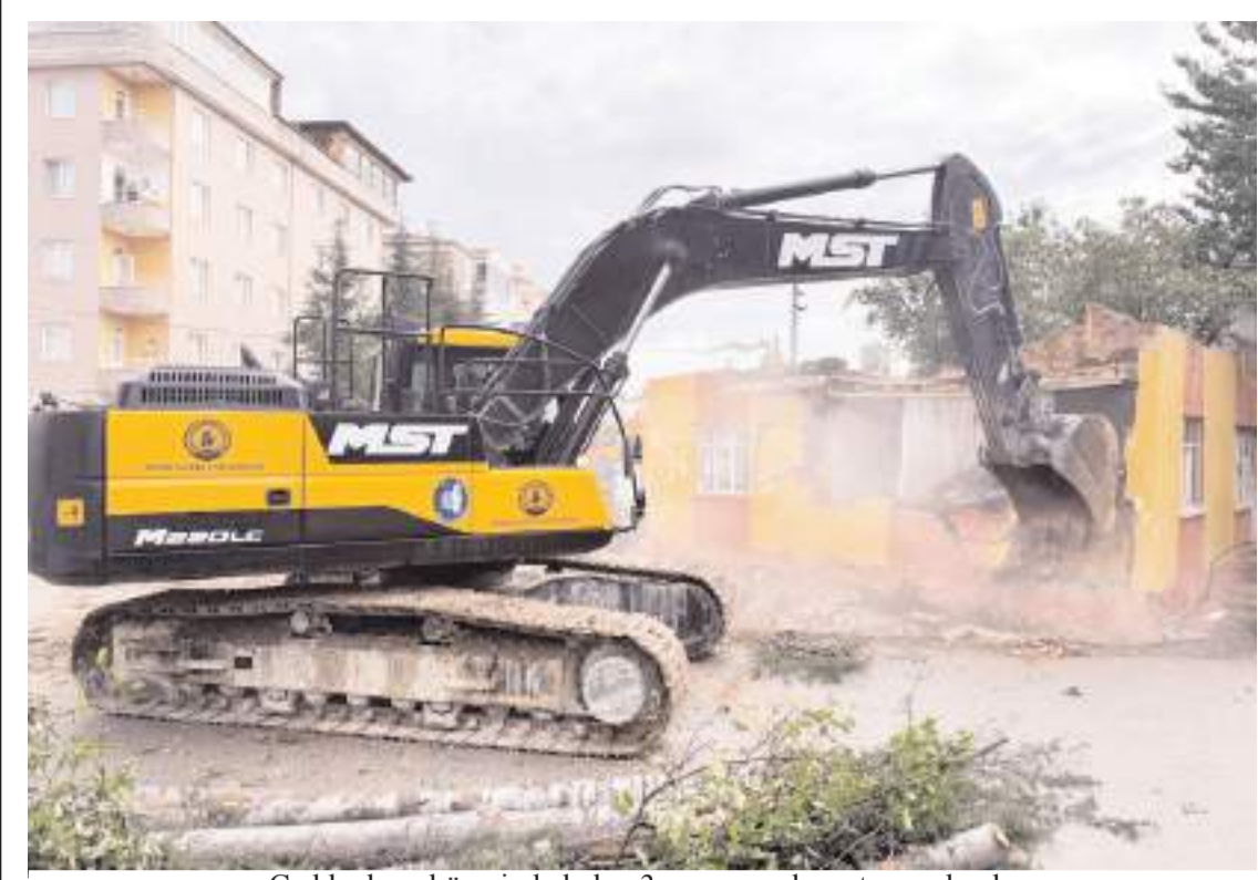
Cadde de yol üzerinde kalan 3 yapının yıkımı tamamlandı.
