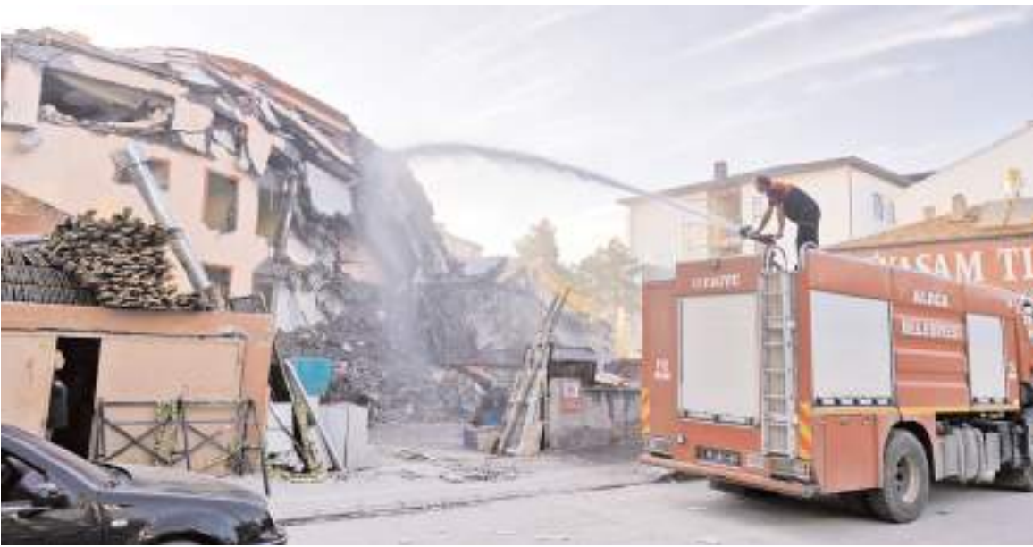
Binanın depreme dayanıksız olduğunun tespit edilmesi nedeniyle yıkımına karar verildi.
