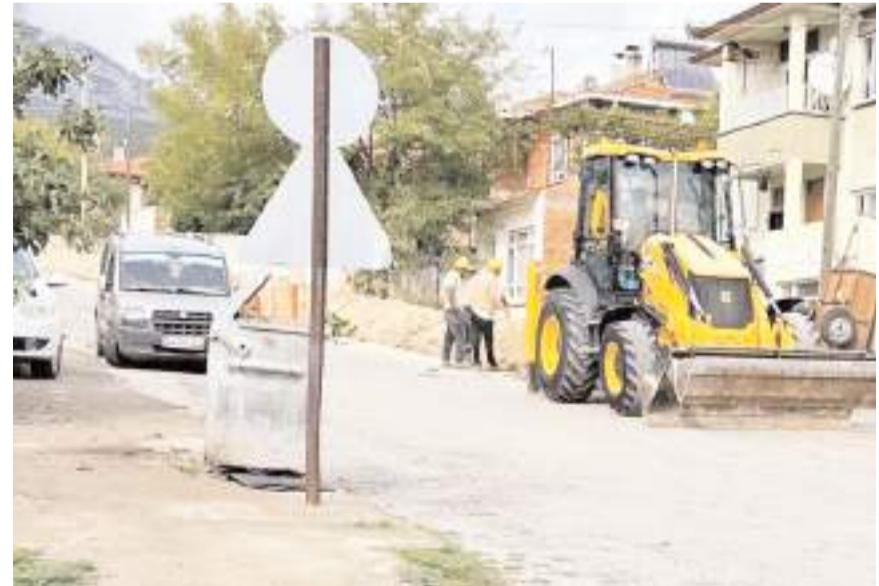
2024 yılında yaklaşık 5 kilometrelik doğalgaz boru hattı döşenecek.
