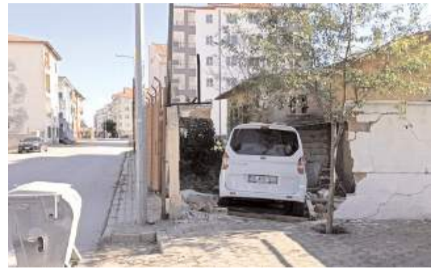
Kaza araçta ve duvarda maddi hasar meydana geldi.
