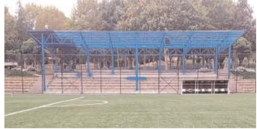
Tribünün çatı kaplama işlemi devam ediyor bu çalışmanın ardından koltuk montaj edilecek
