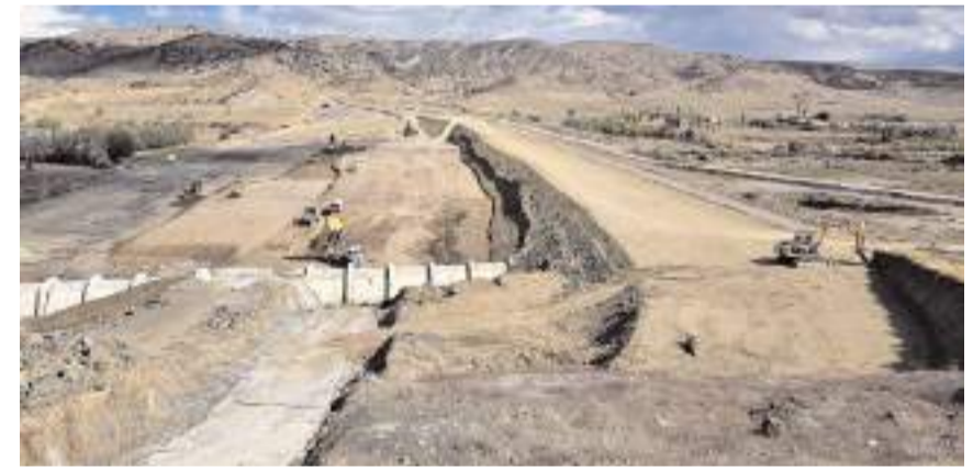
Kırankışla Barajı inşaatında çalışmalar hızla devam ediyor.
