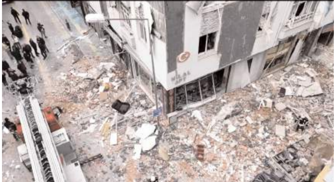
Olay Osmancık Caddesinde 5 katlı Hilal Apartmanında meydana geldi.
