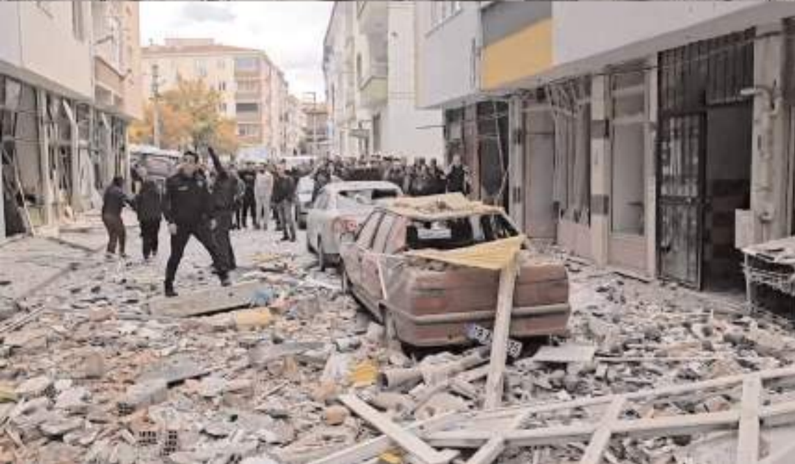
Olay Osmancık Caddesinde 5 katlı Hilal Apartmanında meydana geldi.
