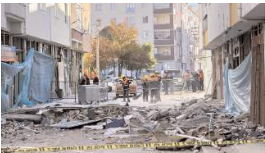
Belediye ekipleri enkaz kaldırma çalışması yaptı.
