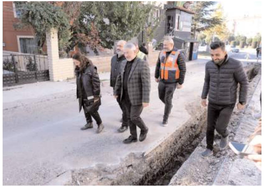
Çorum Belediyesi Binevler'de içmesuyu şebekesini yenilemek için çalışma yapıyor.
