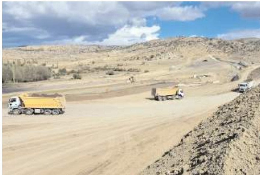
Sungurlu Barajı'nın inşaatı yüzde 52 seviyesine ulaştı.
