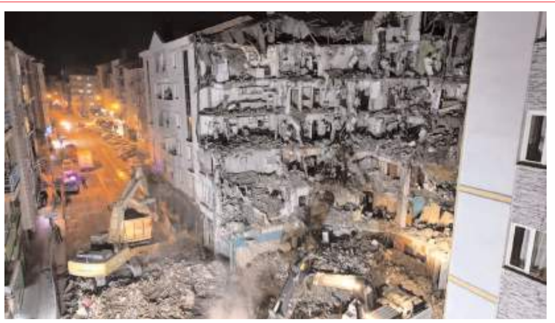
Patlamada hasar gören binanın yıkımına başlandı.
