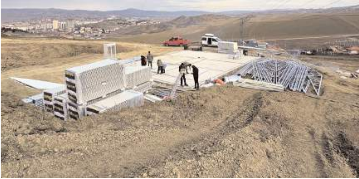
Yüklenici firma inşaat alanına şantiye kuruyor.
