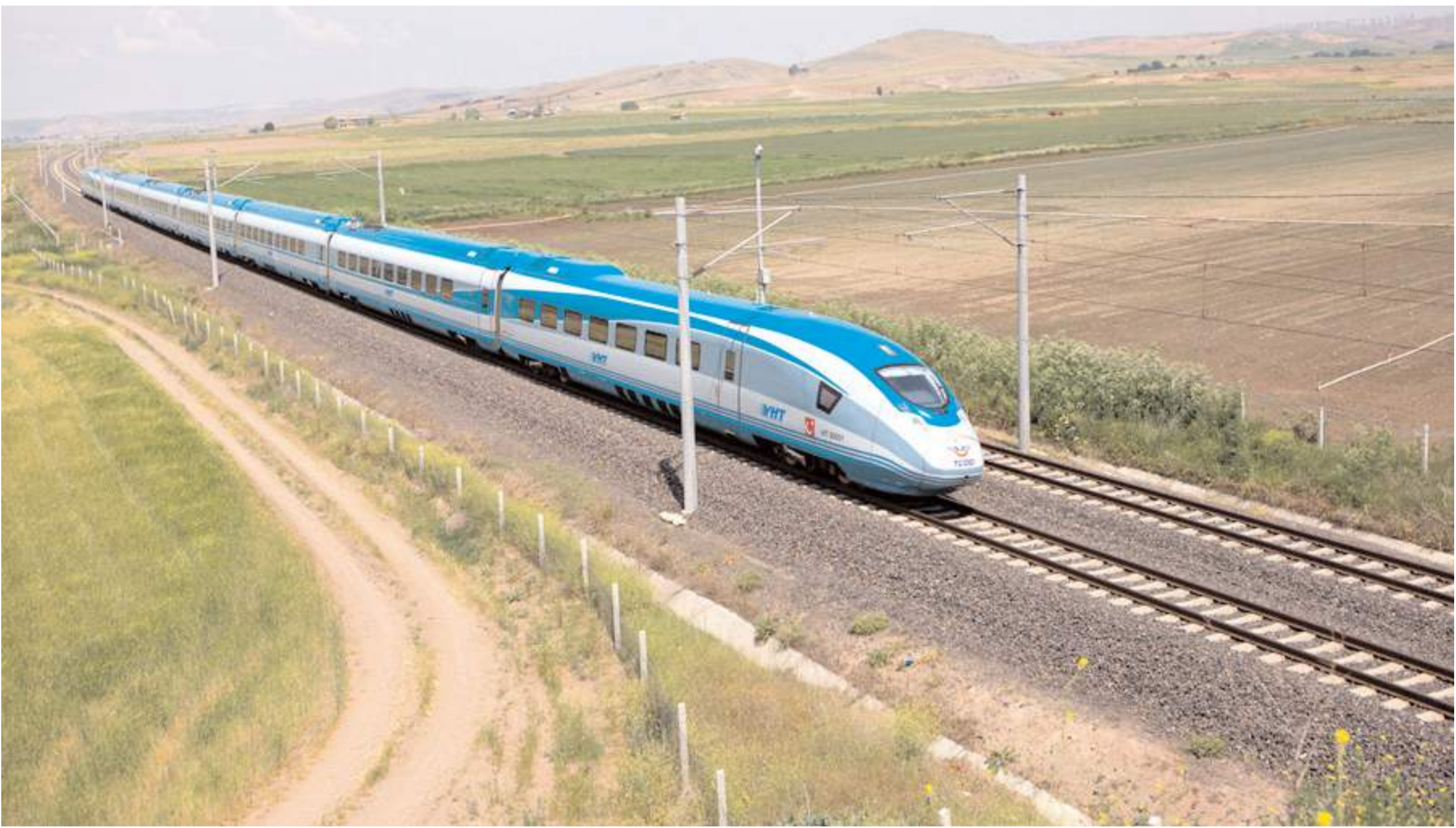
Hızlı tren hattı Kırıkkale'nin Delice ilçesi ile Çorum şehir merkezi arasındaki 120 kilometrelik bir mesafeyi kapsıyor.
