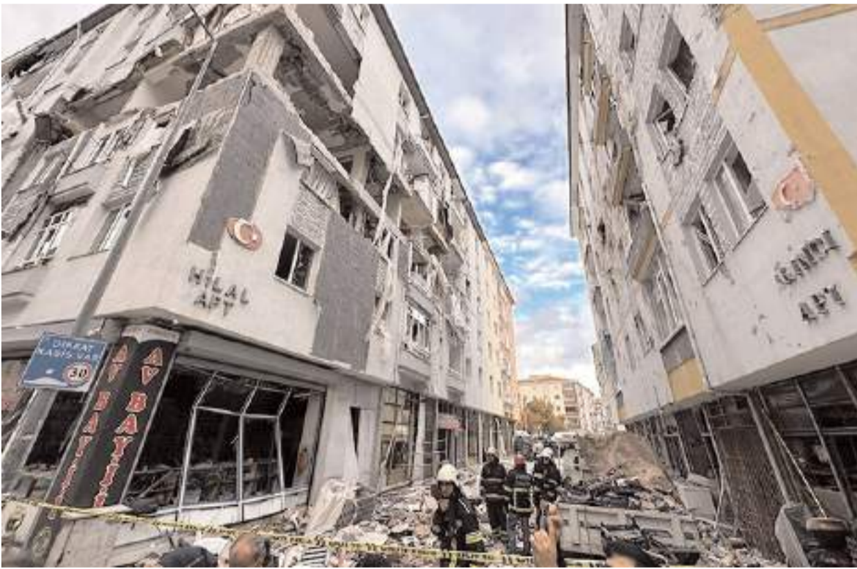
3 Kasım 2024 Pazar günü meydana gelen patlamada Hilal Apartmanı ağır hasar görmüştü.
