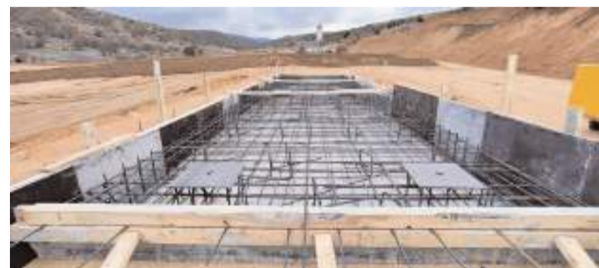
Proje kapsamında güzergah üzerinde 7 kavşak, toplam uzunluğu 3 bin 656 metre olan 4 tünel, 3 bin 652 metrelik 8 viyadük ve 3 otoyol hizmet tesisi yapılacak.
