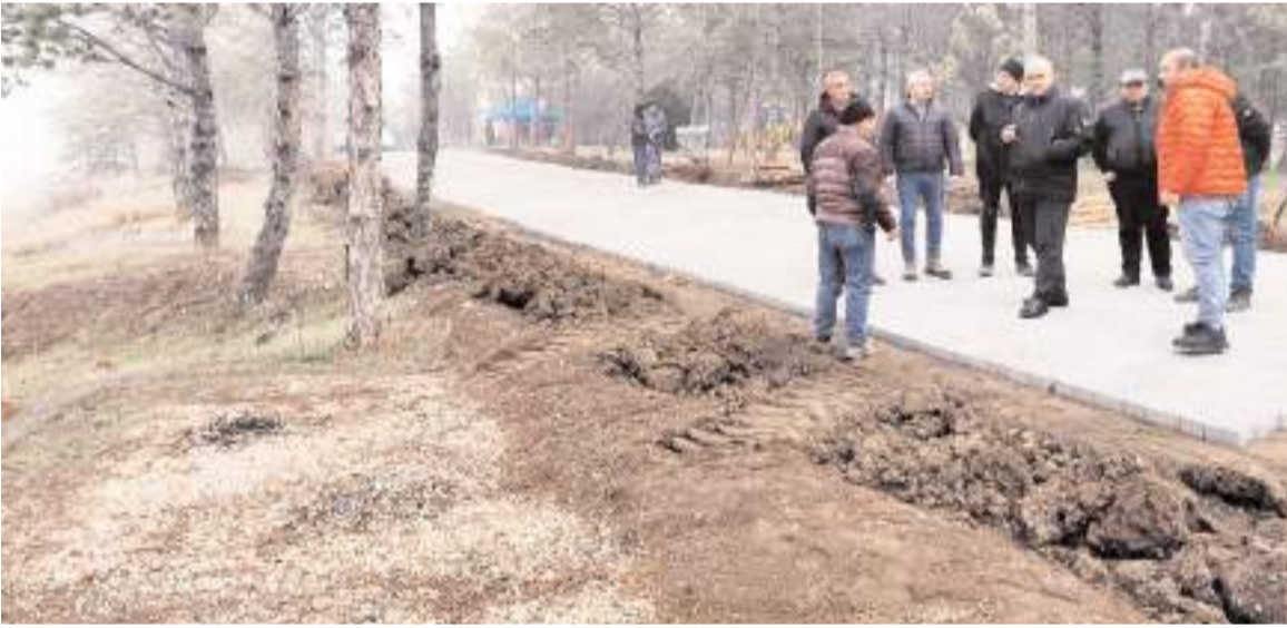
Atatürk Orman Çiftliğinde bakım ve onarım çalışmaları başladı.
