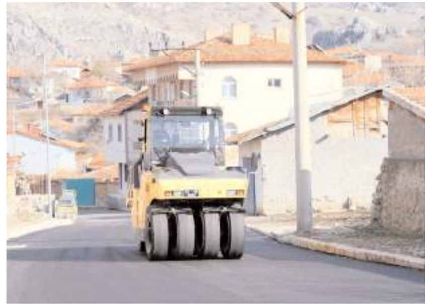
500 metre uzunluğundaki Recep Tayyip Erdoğan Caddesi asfaltlandı.
