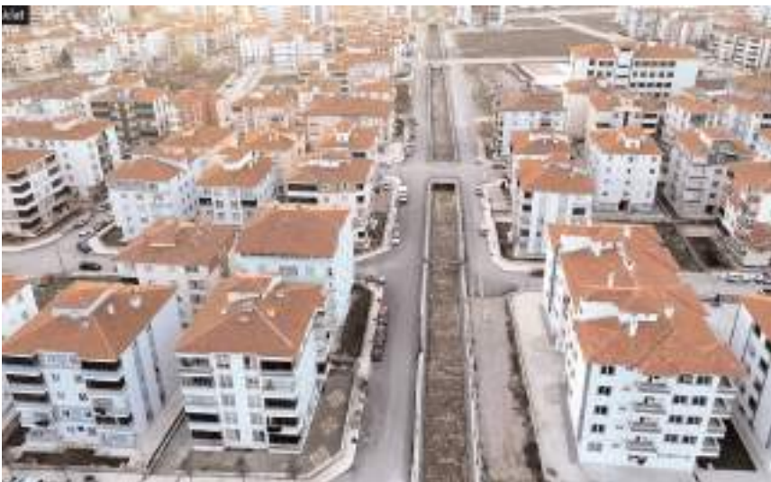
İbrahim Çayırı Kuru Deresi'nde 1260 metre kagir taş duvar ve 5 menfez yapısı imalatı tamamlandı.
