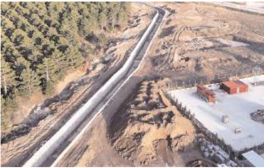
Sıklık Deresi'nde 1100 metre kagir taş duvar ve 3 menfez yapısı imalatları tamamlandı.
