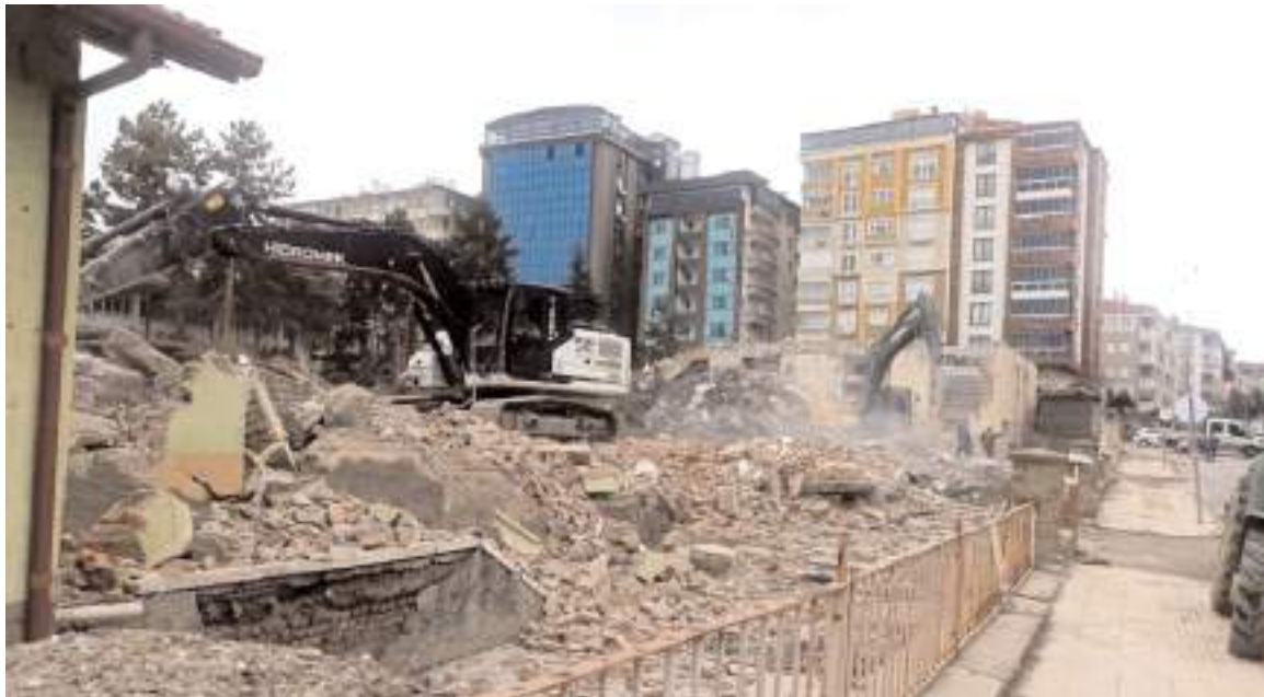
Merkezin yapılacağı yerde bulunan eski yapıların yıkımı başladı.
