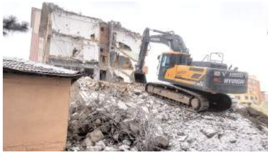
Merkezin yapılacağı yerde bulunan eski yapıların yıkımı başladı.
