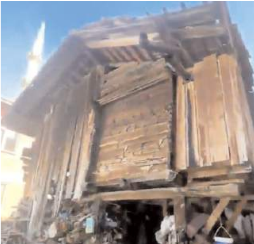
Şehidin ailesinin ahşap evi yeniden yapılacak.
