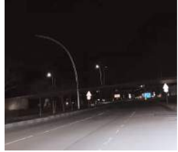
Akşemseddin Kavşağında gerek köprü altı gerekse yan yollarda aydınlatma sorunu yaşanıyor.
