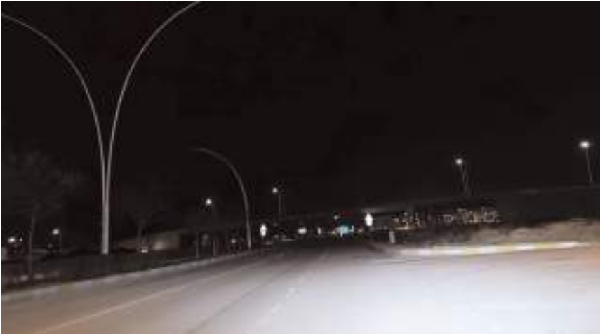
Akşemseddin Kavşağında gerek köprü altı gerekse yan yollarda aydınlatma sorunu yaşanıyor.
