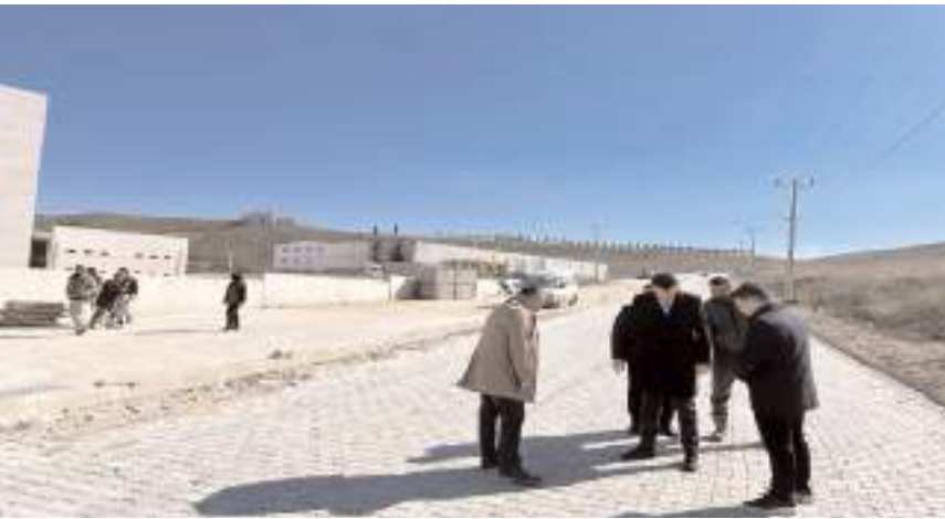
Kaymakam Mutlu Köksal, OSB'de devam eden yol ve altyapı çalışmalarını yerinde inceledi.
