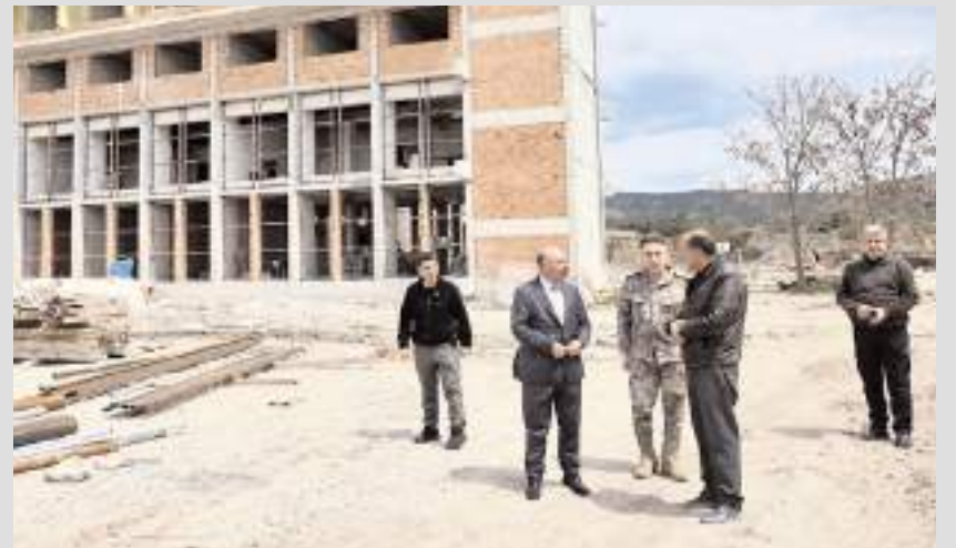
Vali Çalgan, Polis Moral Eğitim ve Kongre Merkezi inşaatında incelemelerde bulundu.
