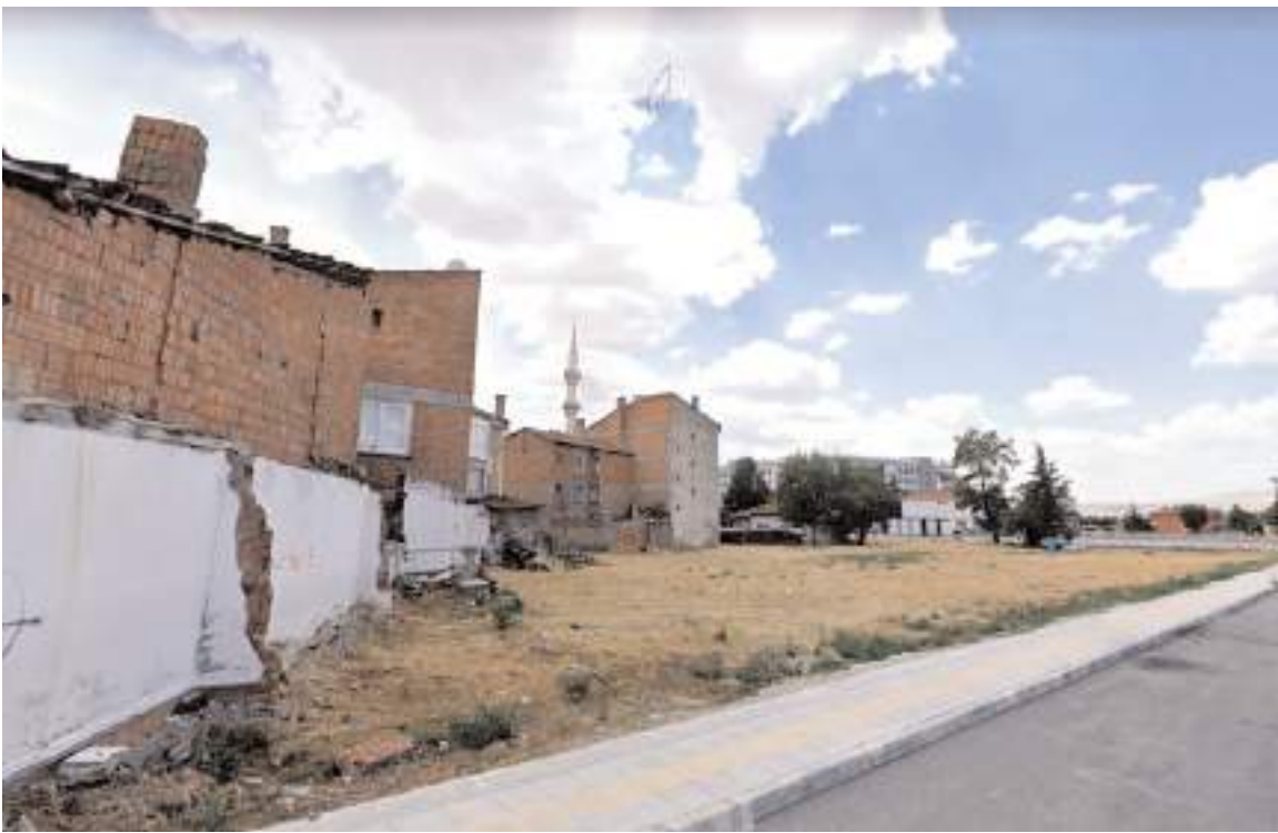
Kunduzhan Aile Sağlık Merkezi ve 112 Acil Sağlık Hizmetleri İstasyonu Devane Cami yakınına inşaa edilecek.
