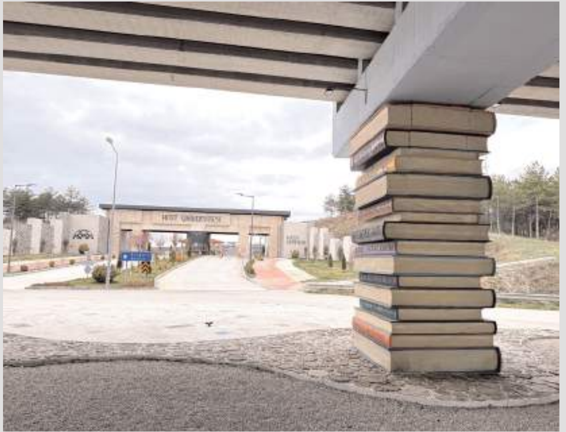
Köprülülük kavşak Çorum Belediyesi'nin gerçekleştirdiği çalışmayla estetik görünüme kavuşturuldu.
