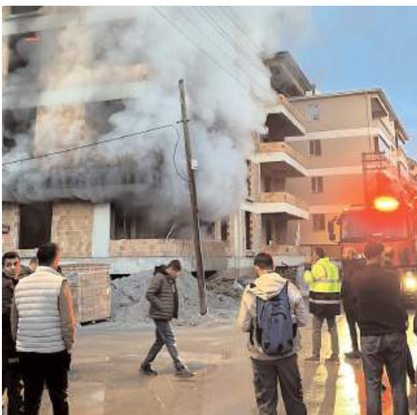
Yangında binada hasar oluştu.
