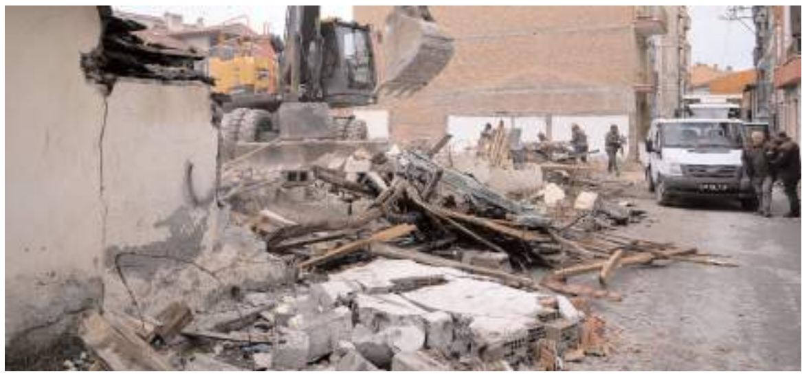
Kale Mahallesi Milönü 3. Sokak'taki metruk binalar yıkıldı.
