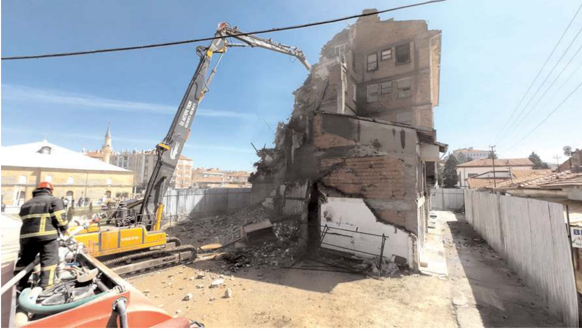
Tarihi Şehir Meydanı'nda yer alan eski binanın yıkımına başlandı.
