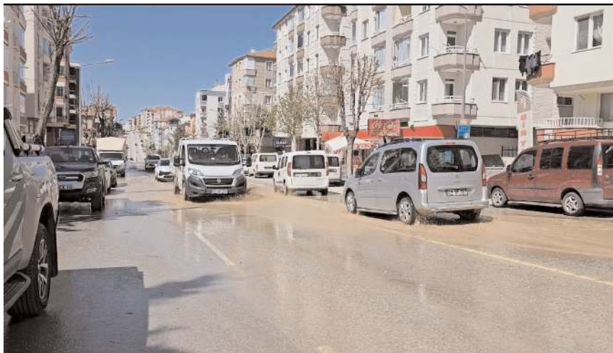
Patlayan su borusu nedeniyle cadde göle döndü.
