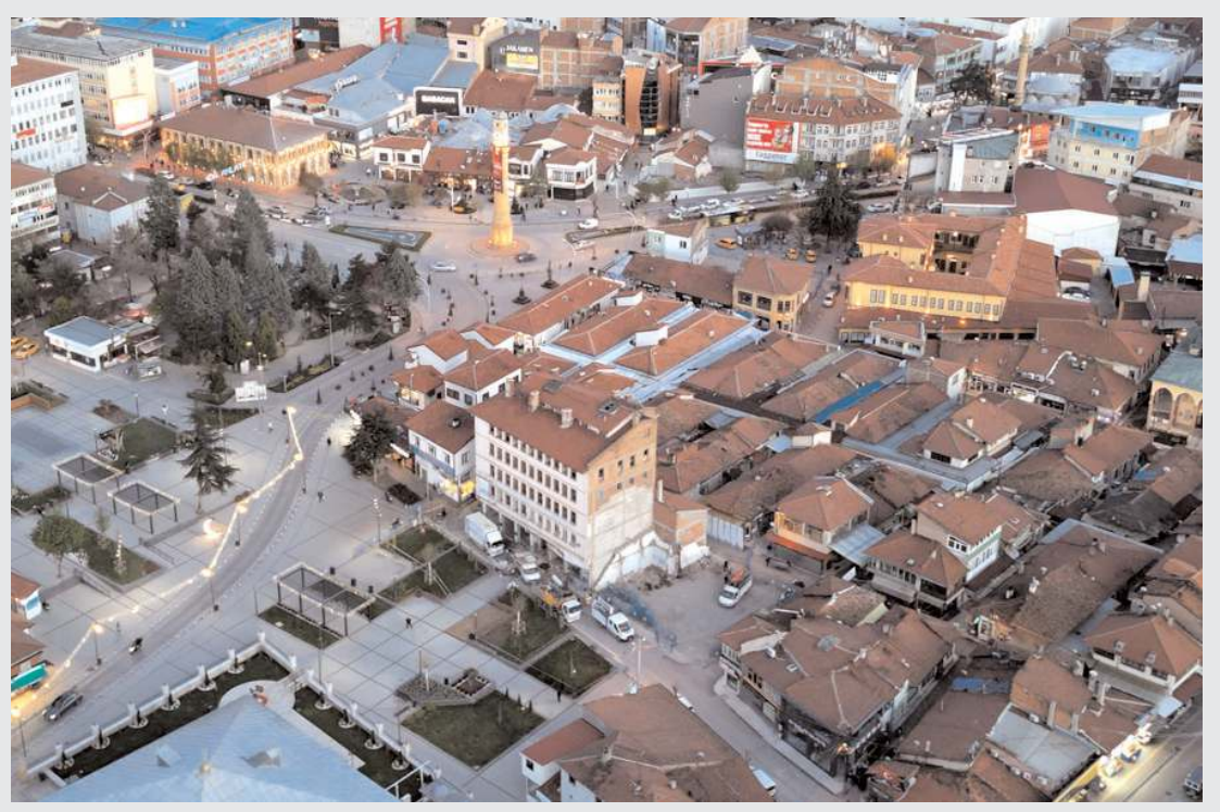
Çorum Belediyesi, Tarihi Şehir Meydanı projesinde çalışmalarına devam ediyor.
