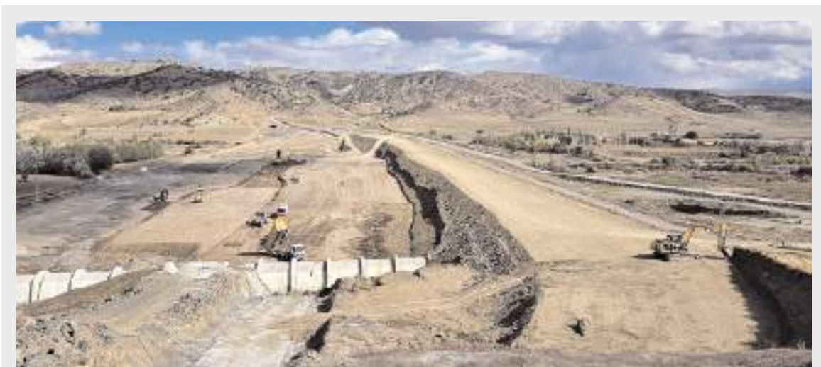
DSİ 5. Bölge Müdürü İbrahim Yaroğlu, Sungurlu Barajı inşaatına 186 milyon lira aktarıldığını söyledi.
