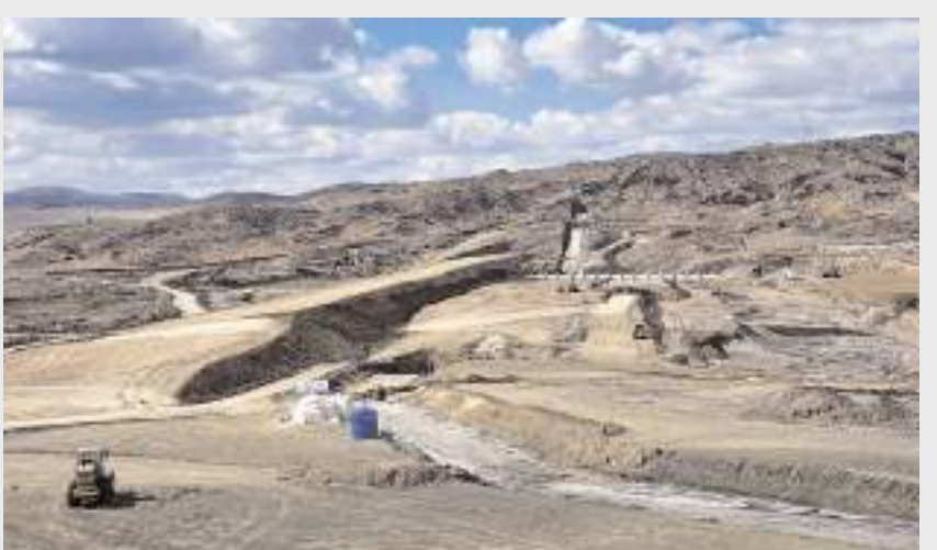
Barajın bu yıl tamamlanması hedefleniyor.
