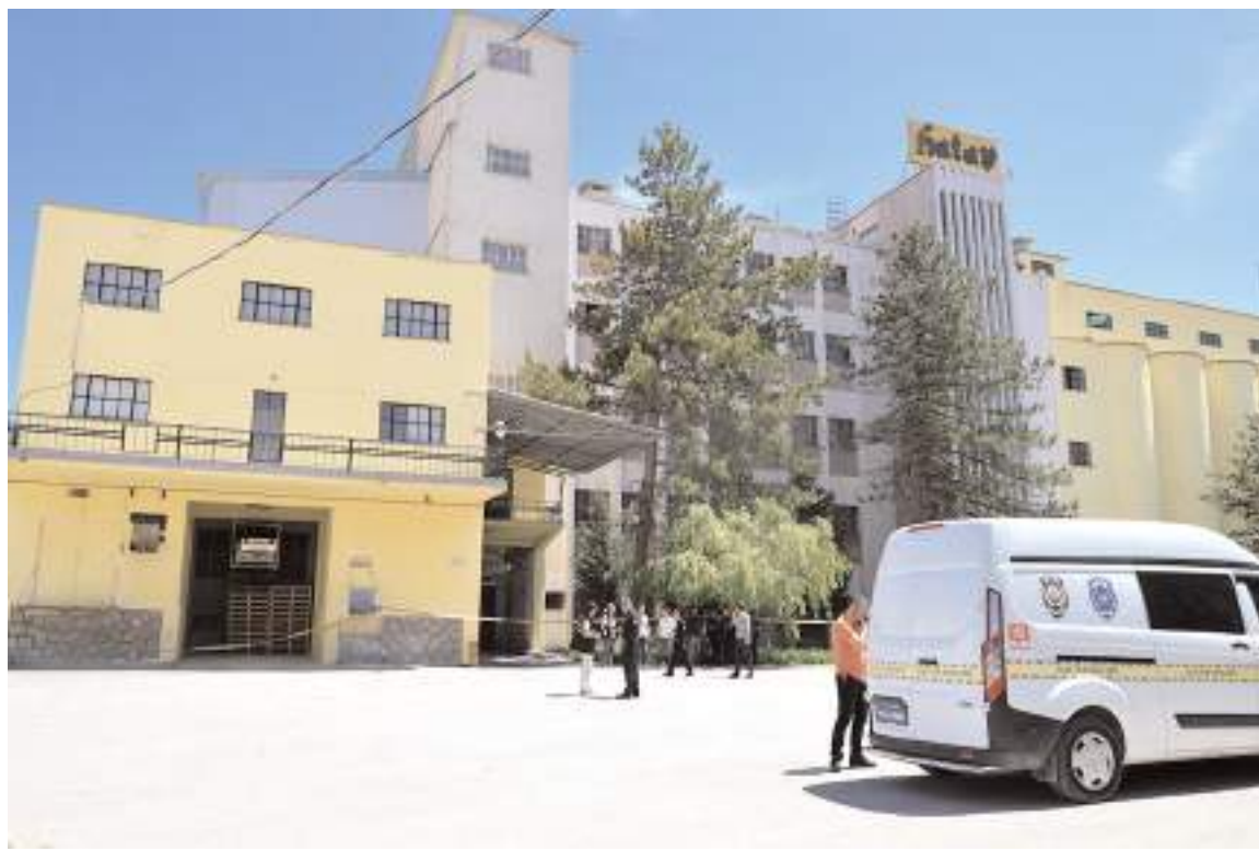
Hatap Un Fabrikası'nın paketleme ünitesinde hava basıncı kaynaklı patlama yaşandı.
