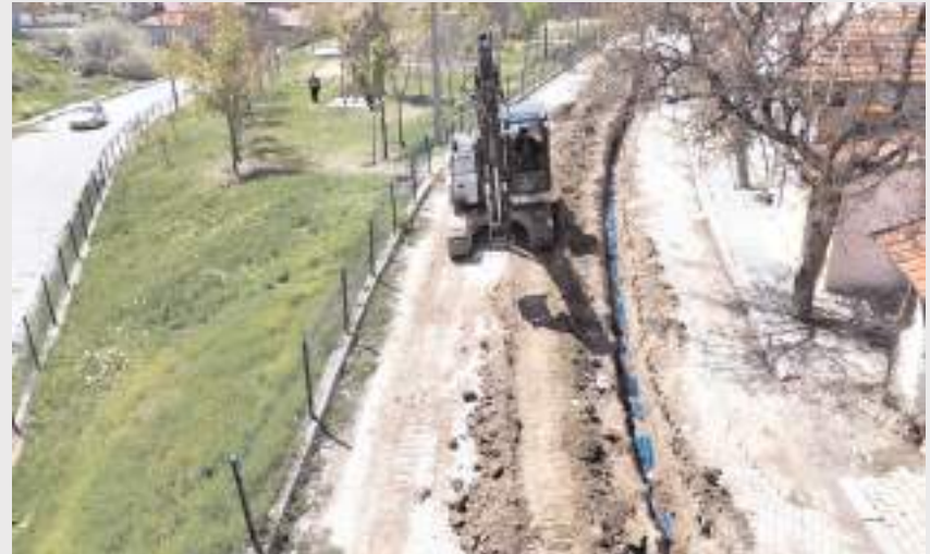
Asbestli borular değiştiriliyor.
