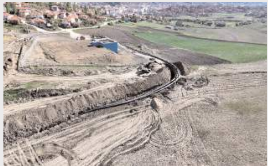
Proje kapsamında 212 kilometrelik içme suyu hattının 2026 sonuna kadar yenilenmesi planlanıyor.
