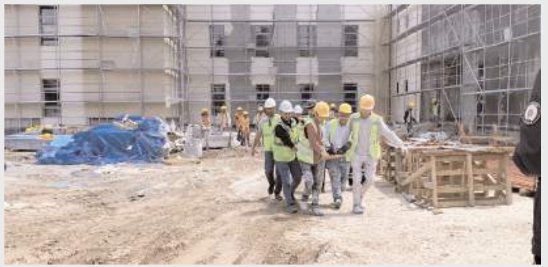
Olay, Bahçelievler Çamlık Caddesi'ndeki hastane inşaat alanında meydana geldi.
