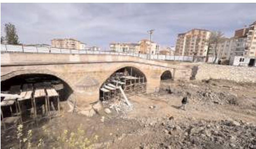
Paşa Köprüsü (Taş Köprü) Karayolları Genel Müdürlüğü tarafından restore ettiriliyor.
