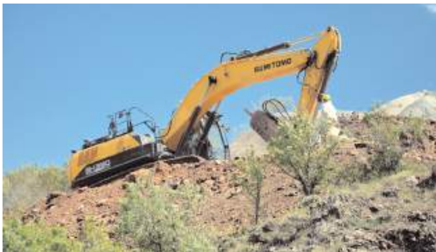
Ekipler tünellerin giriş ve çıkışlarında düzenleme yapıyor.
