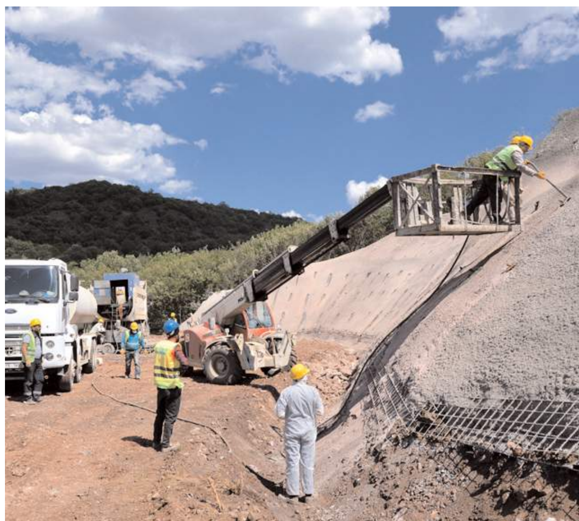
Koparan mevkiindeki T-5, T-6 ve T7 tünellerindeki çalışmalardan görüntü.
