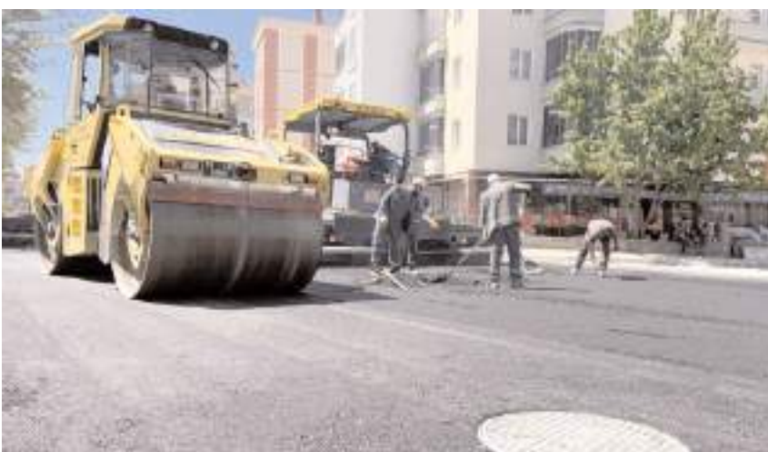
Belediye 370 metre uzunluğundaki yolda yenileme yaptı.
