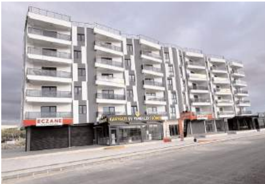
Karabeyoğlu İnşaatın Erol Olçok Eğitim ve Araştırma Hastanesi Acil Servis girişinin karşısında yer alan projesi
