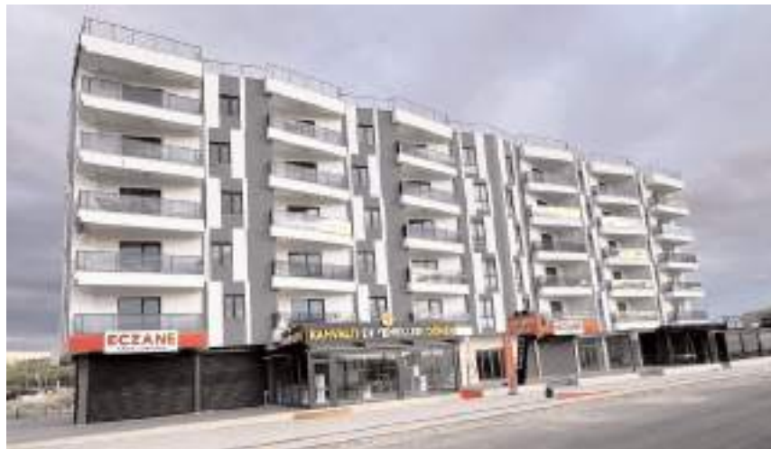
Karabeyoğlu İnşaatın Erol Olçok Eğitim ve Araştırma Hastanesi Acil Servis girişinin karşısında yer alan projesi
