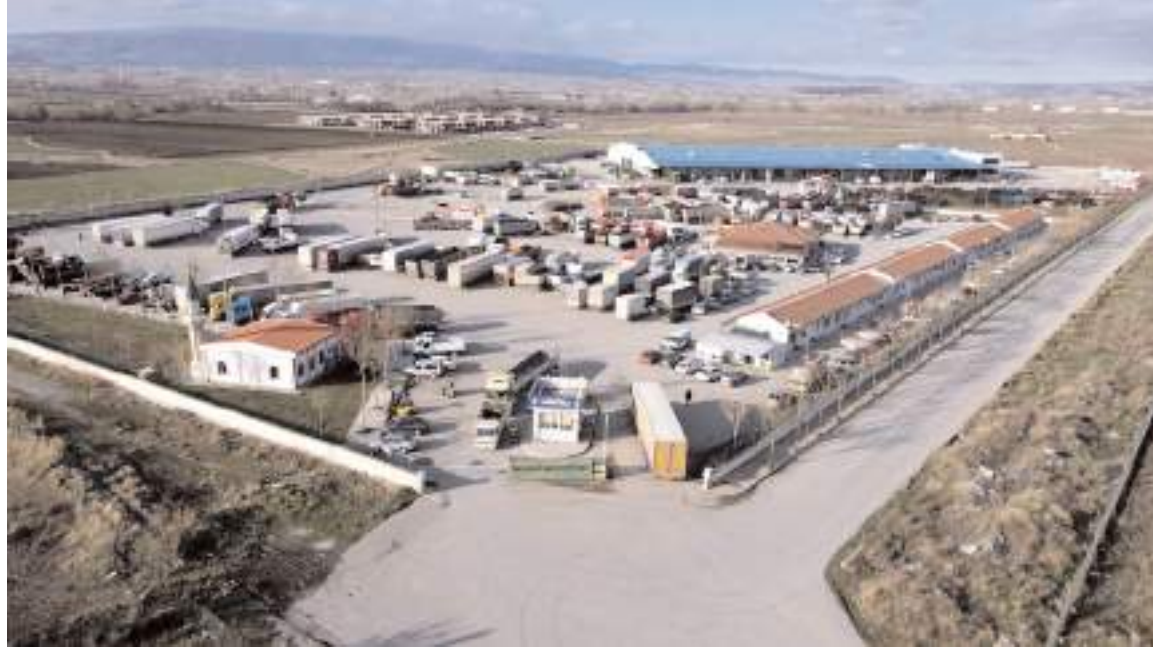
Nakliyeciler Sitesi ve Kamyon Garajı Çorum Belediyesi tarafından işletiliyor.
