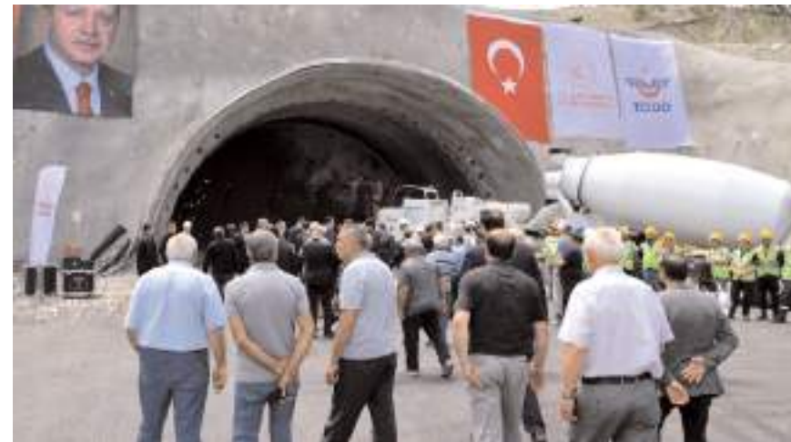
Proje kapsamında Koparan'da tünel çalışması yapılıyor.
