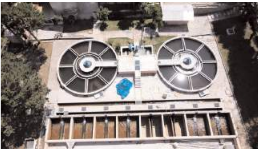
Suyu Arıtma Tesisi'nin kapasitesi yapılacak çalışmayla dört kat artacak.
