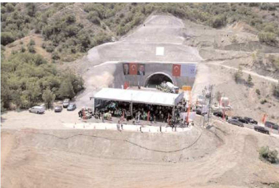
Projenin 3,5-4 yılda tamamlanması hedefleniyor.
