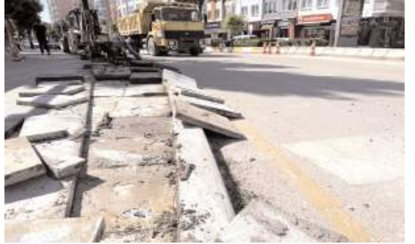
Bahabey Caddesi ile Gazi Caddesinin birleştiği noktada yol genişletme çalışması yapılıyor.
