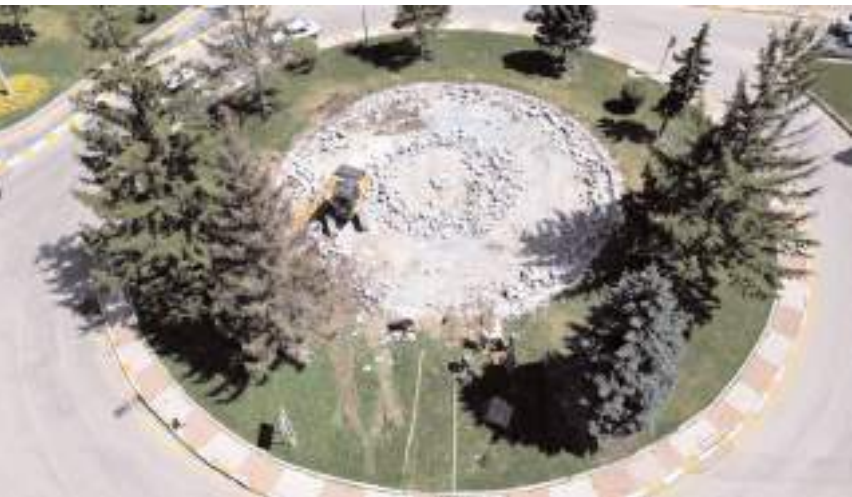
Kavşakta bulunan eski havuz yıkıldı.
