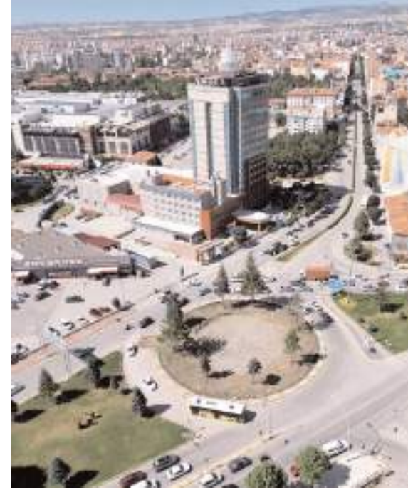
Çalışmalar kapsamında kavşakta bulunan eski havuz yıkıldı.
