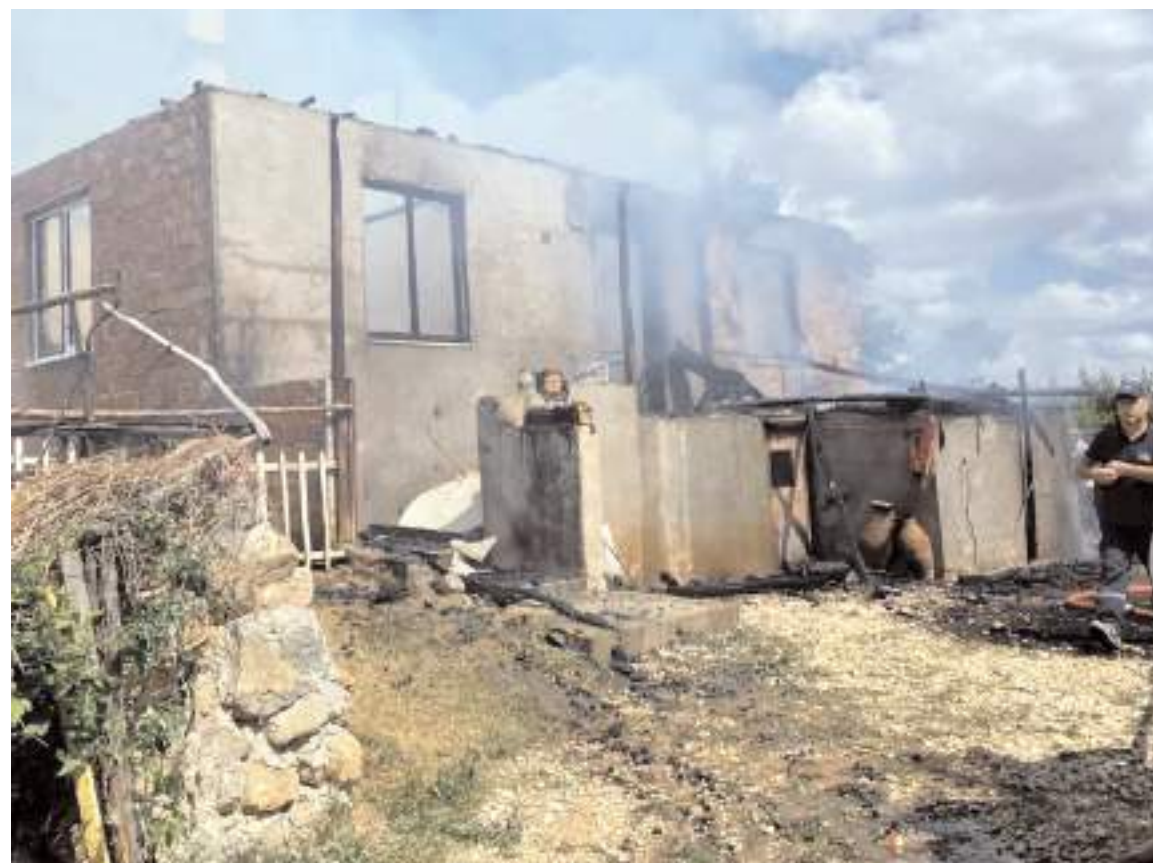
İtfaiye ekipleri yangını diğeri evlere sıçramadan söndürdü.
