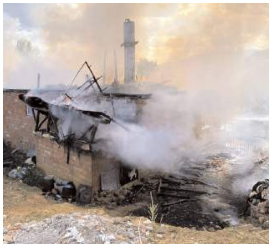
Elektrik kontağından çıkan yangında ev kullanılamaz hale geldi.
