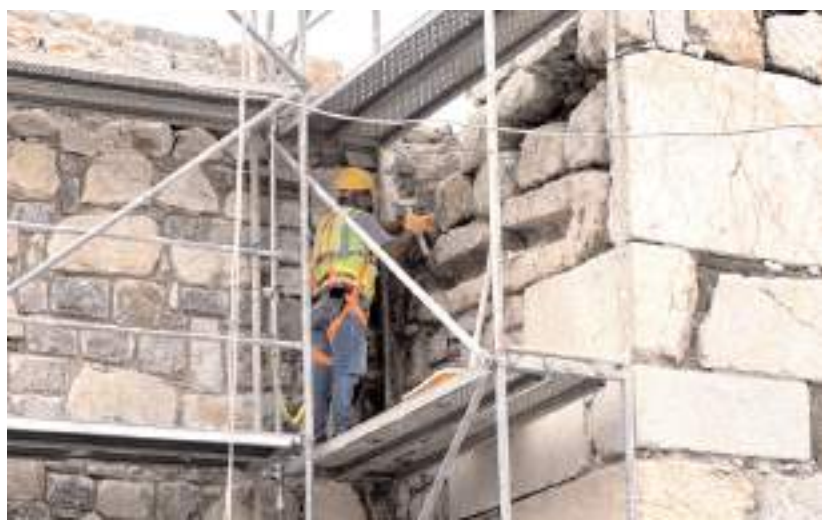
Restorasyon çalışmaları kapsamında kalenin beden duvarları onarılıyor.
