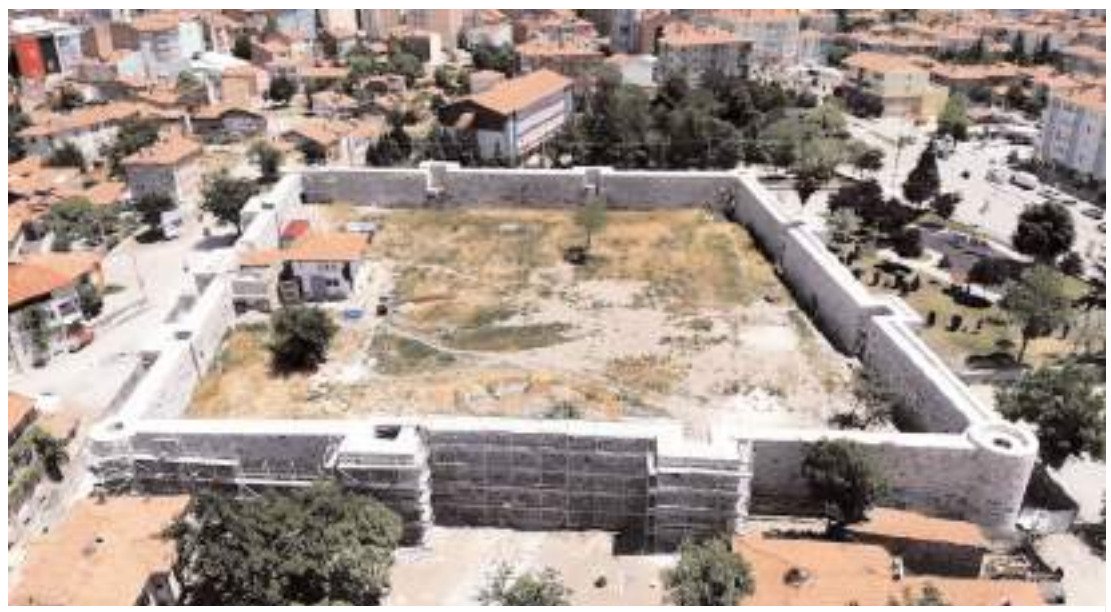
11'inci yüzyılda inşa ettirildiği tahmin edilen Çorum Kalesi'nde 2023 yılında başlayan restorasyon çalışmaları sürüyor.
