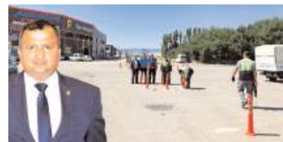
Çorum Sanayi Sitesi'nde yeni bir refüj çalışması başlatıldı.
