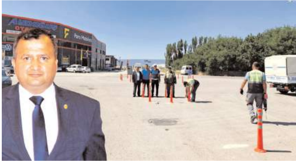
Çorum Sanayi Sitesi'nde yeni bir refüj çalışması başlatıldı.
