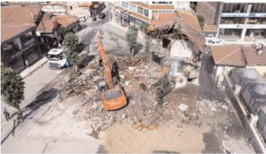
Yıkım çalışması havadan böyle görüntülendi..
