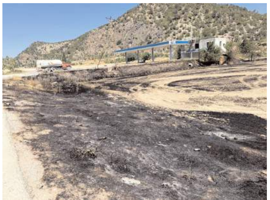
Yangın trafonun patlaması sonucu çıktı ve çevreye yayıldı.
